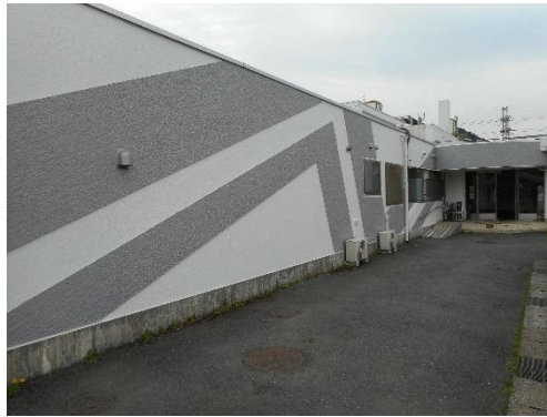
模様が鮮やかになった玄関前の外壁
